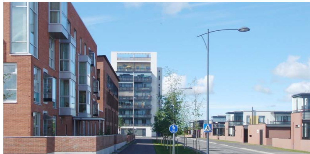
Pääkadun puolelta korttelit on rajattu rakennuksin tai tiilaidoin. Rakennusten suunnittelijat vasemmalta oikealle Arkkitehdit m3 Oy, Juhani Romppainen. Tornitalo ja oikeanpuoleiset rivitalot Arkkitehtiryhmä A6 Oy Kuva: Timo Lajunen 2007.
