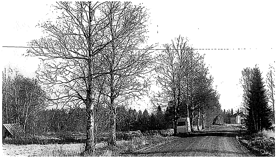
Paikallistien reunassa kasvavaa puustoa voidaan säästää rakentamalla kuivatusojat niiden taakse.
