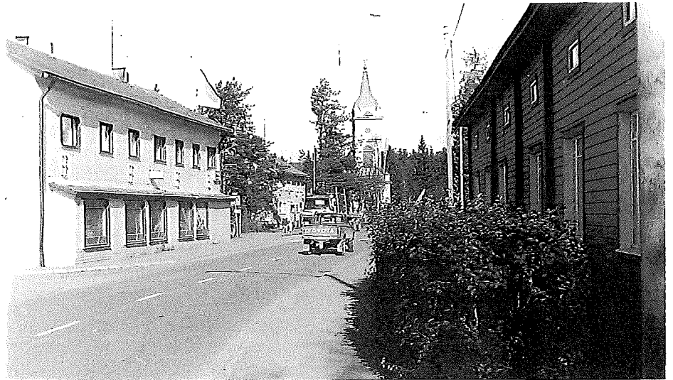
Tie on parannustoimenpiteiden seurauksena noussut aina ylemmäs. Rakennukset ja kasvillisuus jäävät "monttuun".
